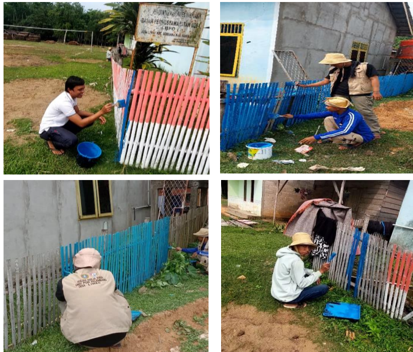
Gambar 2. Pengecatan Ulang Pagar Kantor Desa
